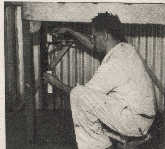
Para saber cuando cambia la densidad del petróleo los técnicos toman sus muestras en el oleoducto.
