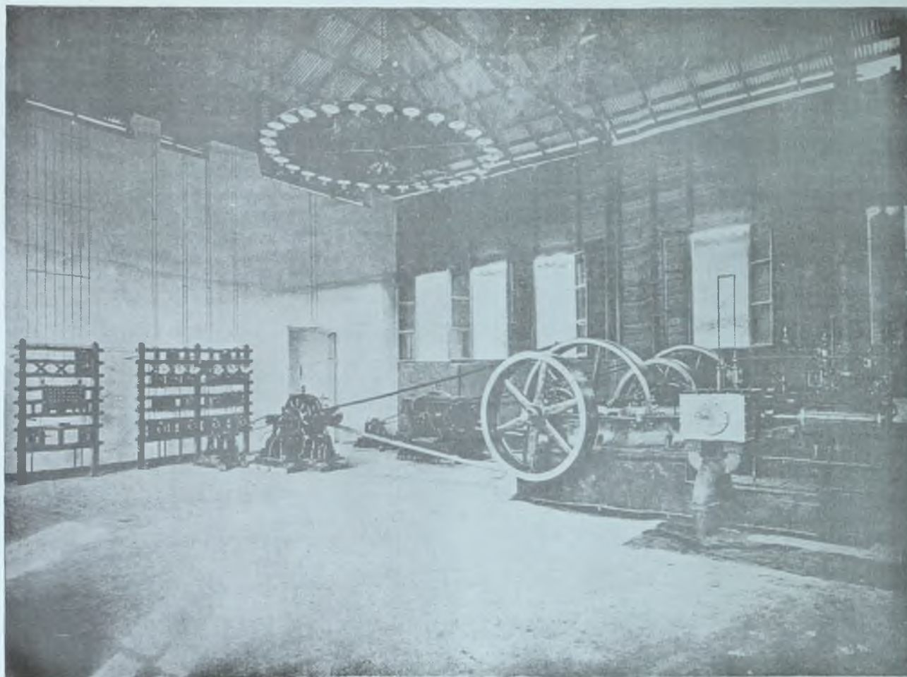
SALÓN DE LA MAQUINARIA. — (Edificio de la luz eléctrica)
