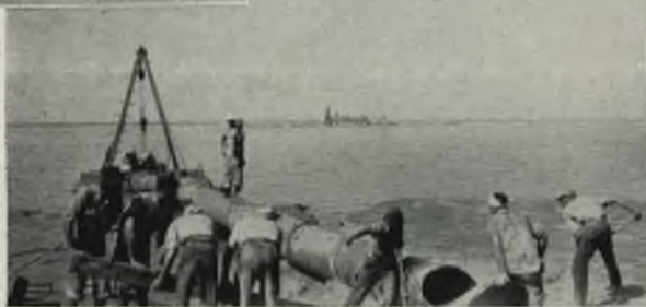
Tubería de succión conectada con la Draga. Tiene 1.000 metros de largo.
