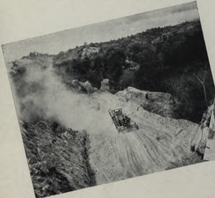
Cuchilla trabajando en corte en el Cerro del Diablo.
