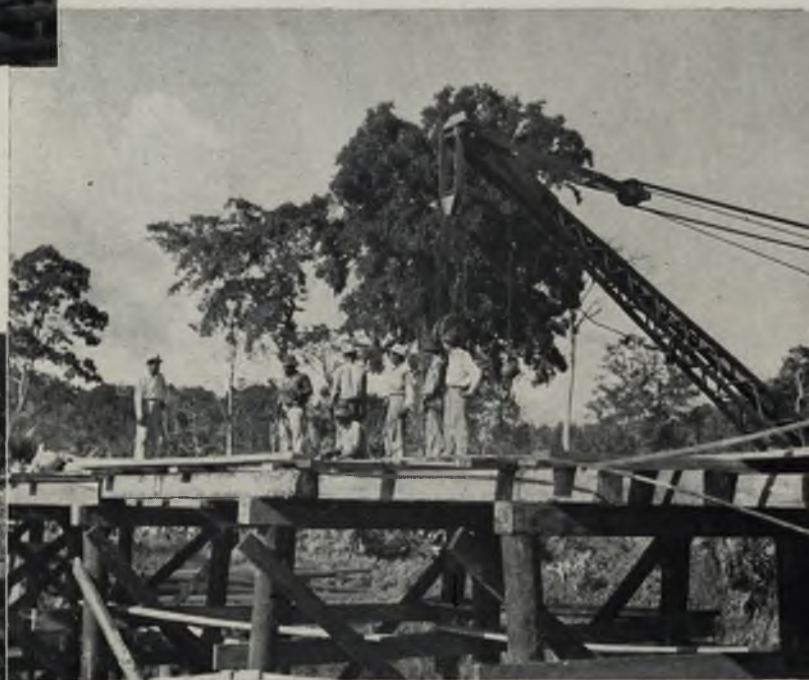
Colocando andamiaje para la erección de la armazón de acero.
