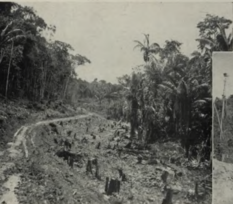
← Tala a lo largo de la vía de la carretera y el corte de guía.
