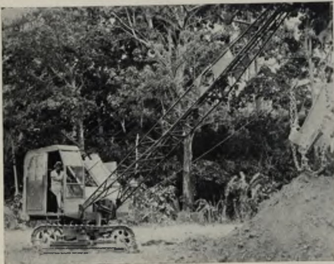
Pala Mecánica haciendo relleno al pie del Cerro del Diablo.
