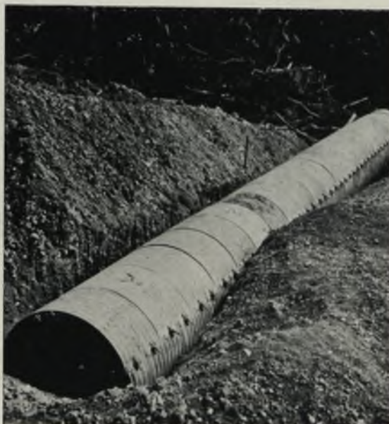
Alcantarilla armada y colocada.
