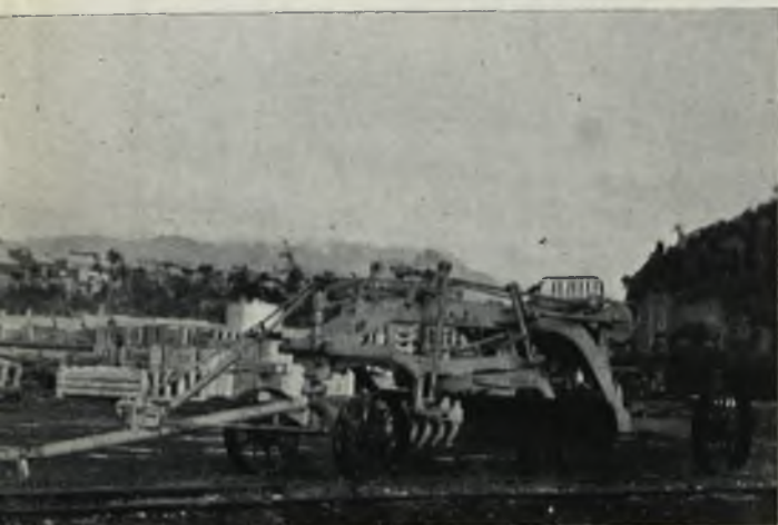
Cuchilla usada en la construcción de la carretera.
