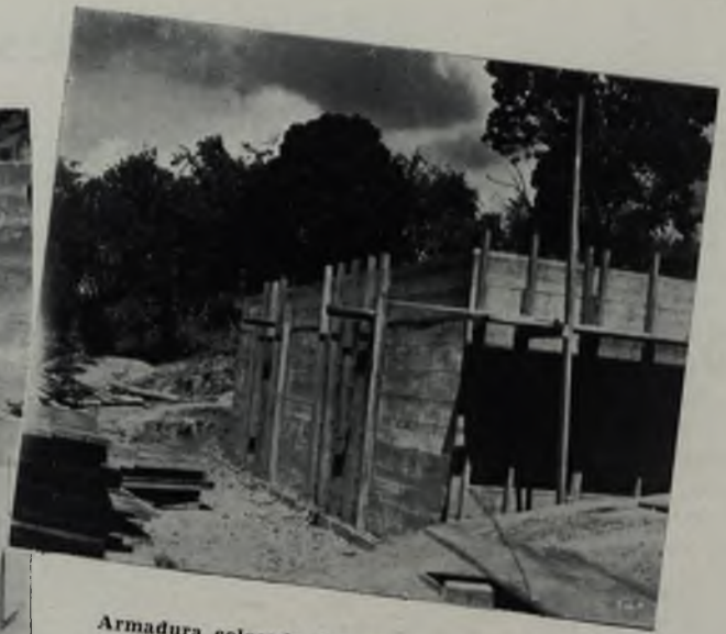
Armadura colocada después de echar pared de concreto del tanque de abastecimiento.
