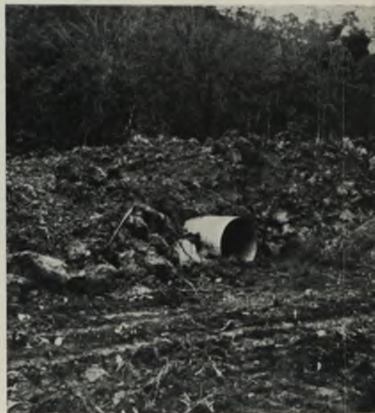
Alcantarilla colocada y parcialmente cubierta.
