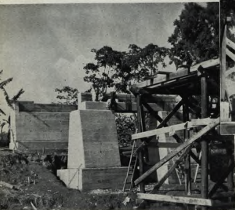
Estribos completados en la orilla norte del Río Caripe.
