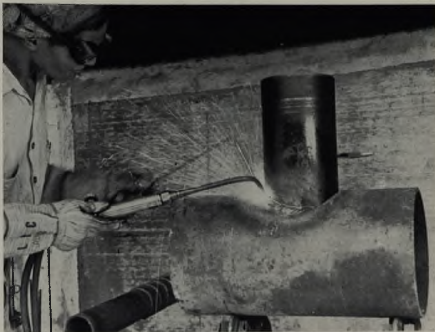
Pedro Suárez empleando la soldadura autógena.
