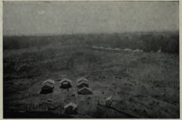
Lo que era el campamento al empezar los trabajos.
