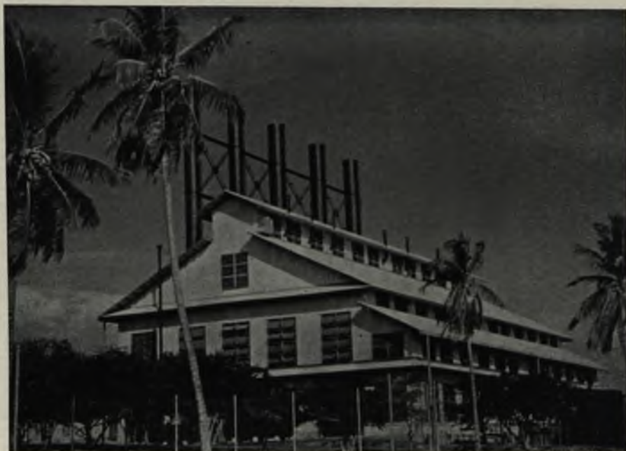
La Planta Eléctrica.
