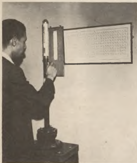
LAS VARIACIONES de la presión atmosférica las aprecia este barómetro.
