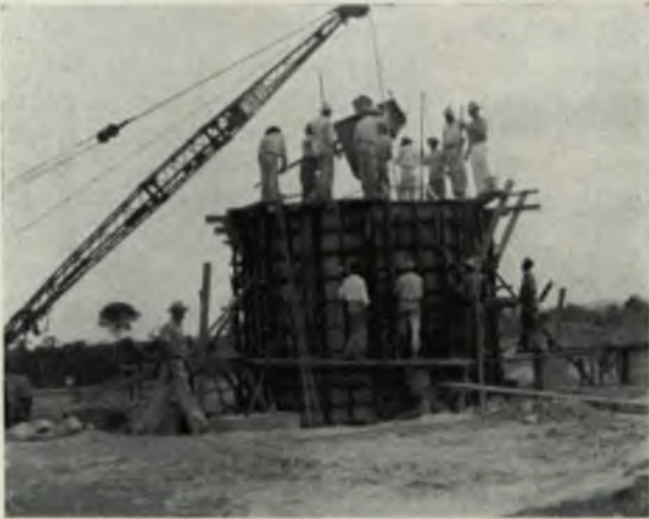
Construcción de una de las torres para las labores industriales de la refinería.
