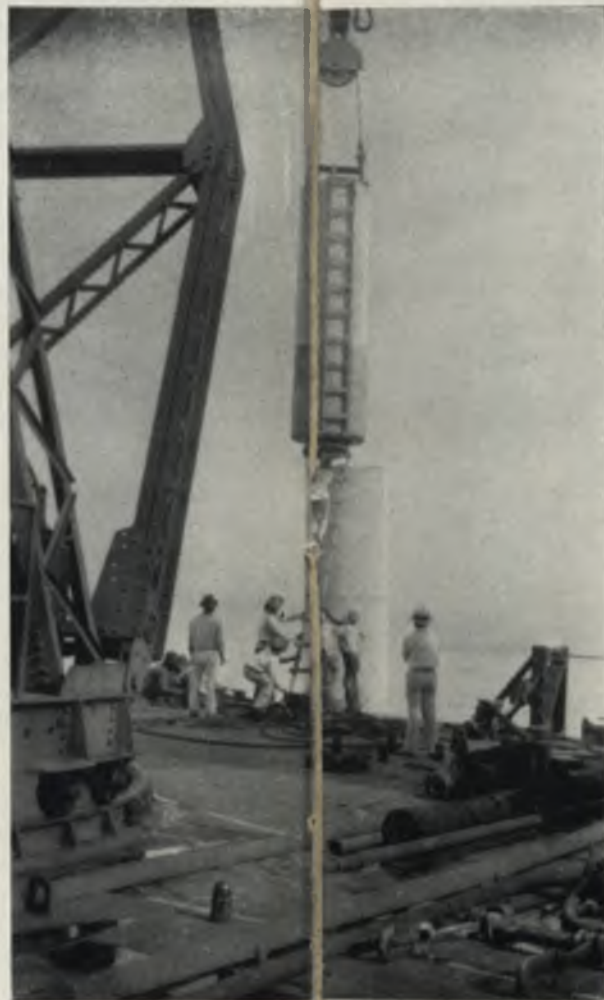
Ya el "pilote" de 93 pies de largo se ha enterrado a causa de su peso y se trabaja ahora por darle mayor profundidad.
