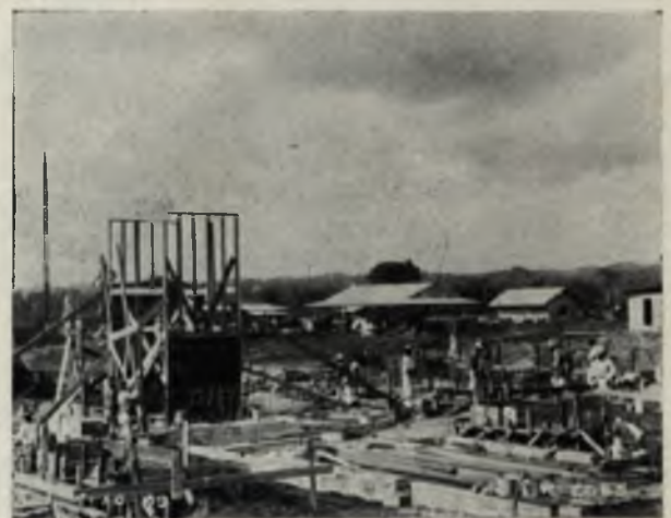
Vista de la construcción de la planta de fuerza eléctrica para el servicio de la refinería.
