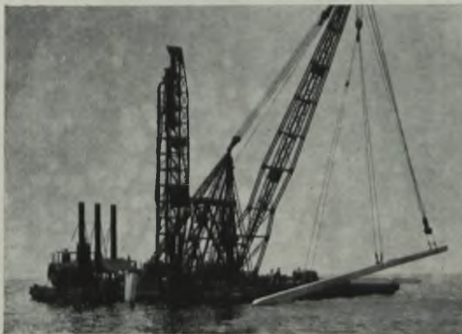
Gabarra de martinete llevando a posición un pilote para clavarlo.
