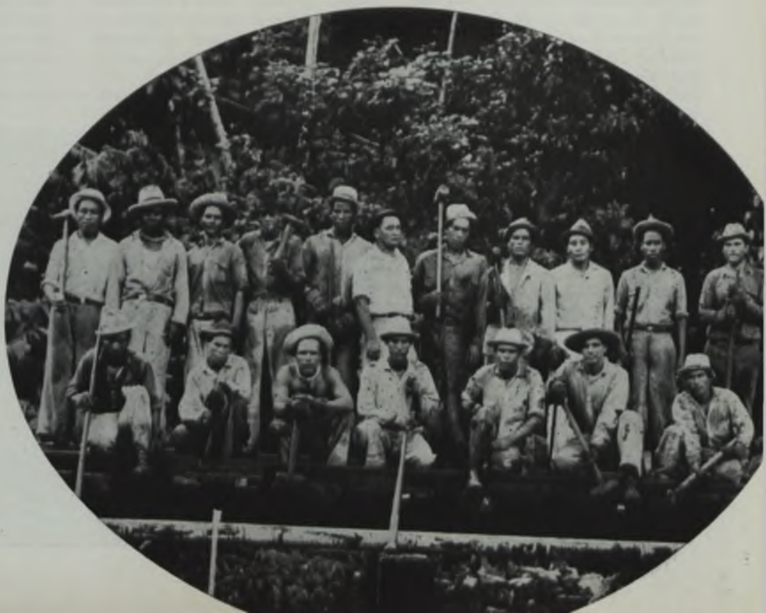
Grupo de trabajadores que actualmente se ocupan en el mantenimiento de la línea férrea de Caripito.
