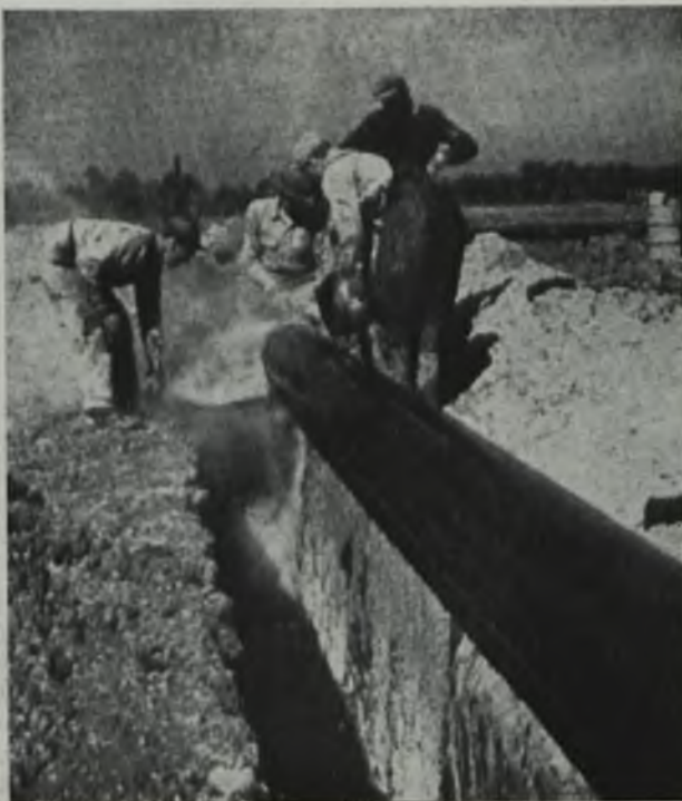
Otro aspecto de la colocación del tubo de acero.
