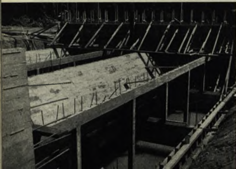
Tanque en que desembocan las alcantarillas.
