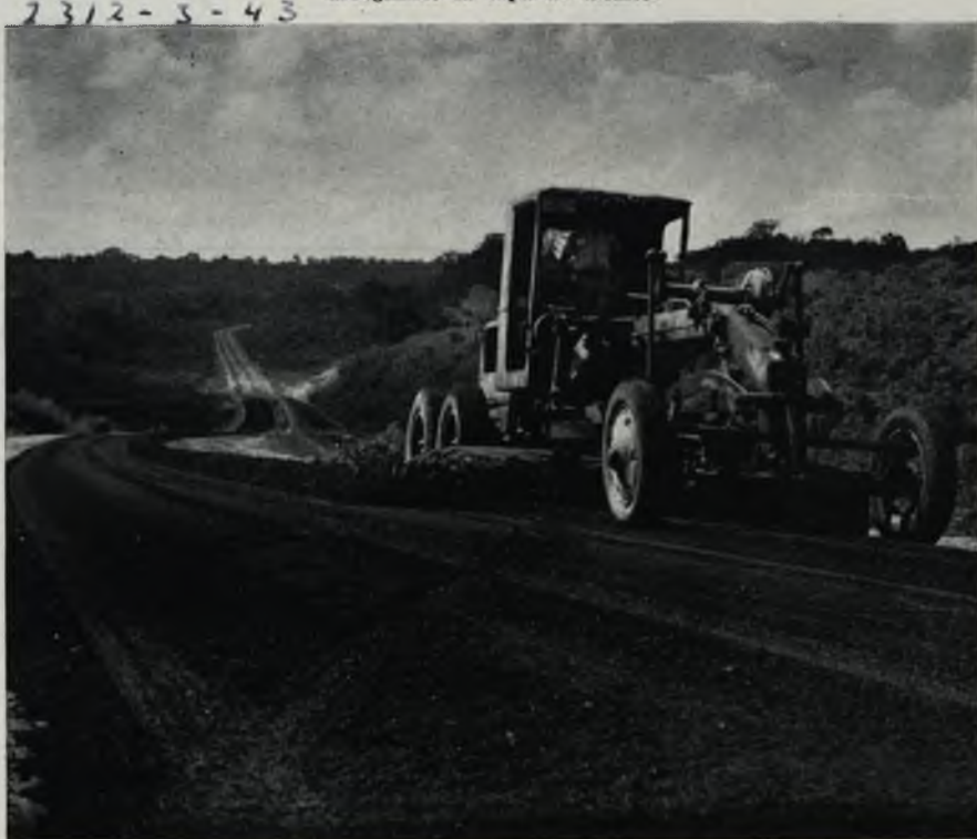
Una sección de la Carretera Quiriquire-Jusepín, donde se ve la máquina niveladora arreglando la capa de asfalto.
