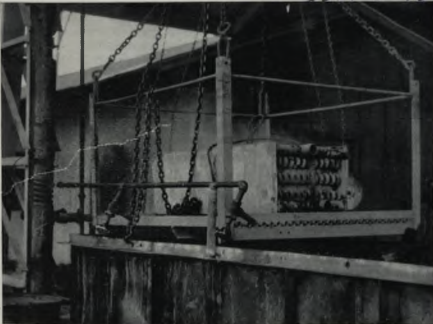
Aparato y tanque de agua caliente que se usa en el Departamento de Conservación de Materiales en Quiriquire, para la reparación y limpieza de éstos.
