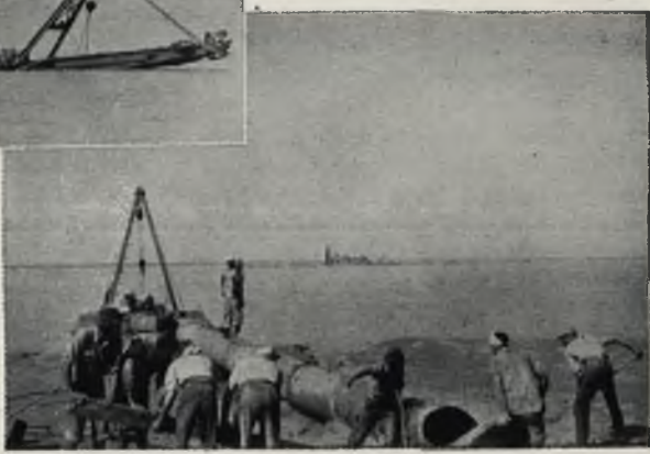
Tubería de succión conectada con la Draga. Tiene 1.000 metros de largo.
