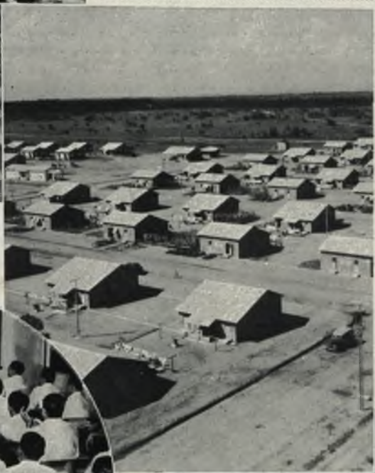
Campamento obrero de Jupépin: viviendas cómodas, sanas y bien aireadas.
