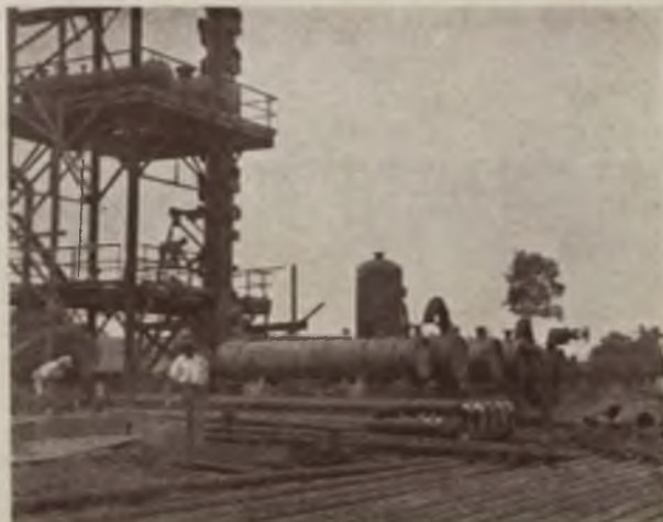
Extremo de la tubería del calentador.
