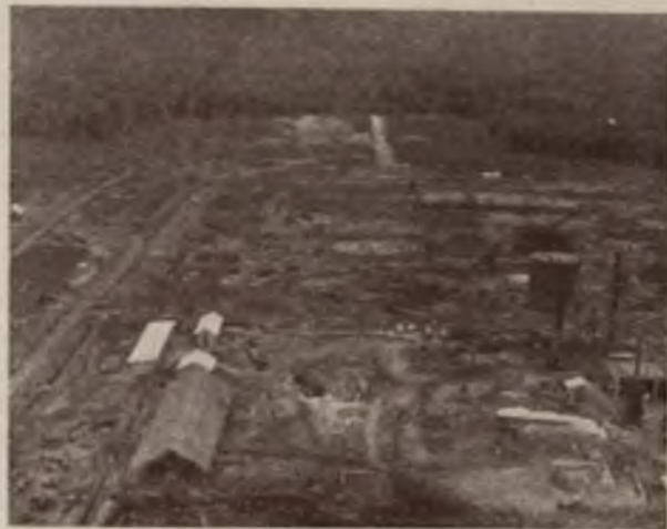
Panorama tomado hacia el Sur desde la chimenea de la planta de calderas.
