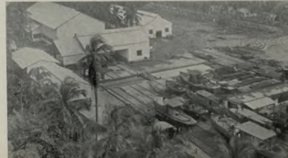
Embarcaciones en reparación con vista de los talleres.
