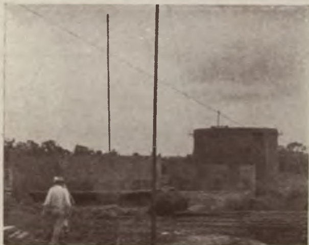
Instalación de los tanques-depósitos.
