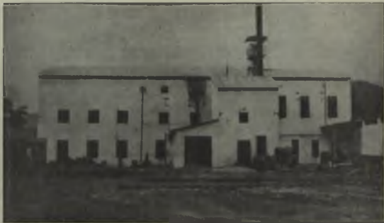
Aspecto parcial de la fábrica de manteca de coco "Compañía Industrial Venezolana", de Puerto Cabello.
