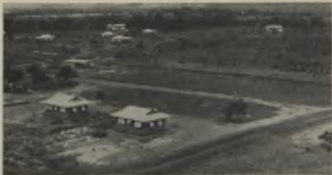
Vista general del Centro de Josepín, de la Creole Petroleum Corporation, en el Estado de la Guayana.
