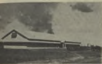
Edificio de la oficina Central de la Creole en Puerto La Cruz.
