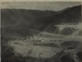
La hermosa zona de Agua Fria de donde se originaron las aguas que serán conducidas al acueducto de Caracas por medio de la línea de transmisión de Macarao a Caracas y el canal del río Turmerito a La Mariposa.
