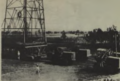
La cabria, antes de ser elevada y estabilizada por sus cables, se encuentra en posición de marcha.
