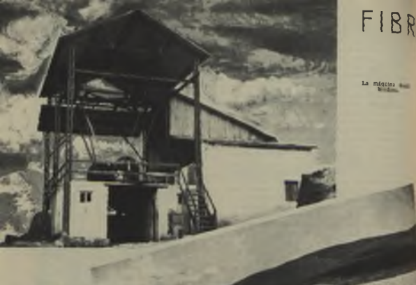
Sección de las maquinarias de fibra de la cañiza.
