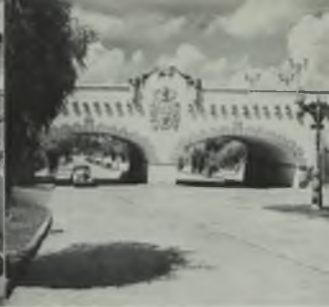
Puentes sencillos, una avenida y líneas utilizadas en proyectos de obras asociadas de las urbanizaciones y la ciudad. Los Cabos.
