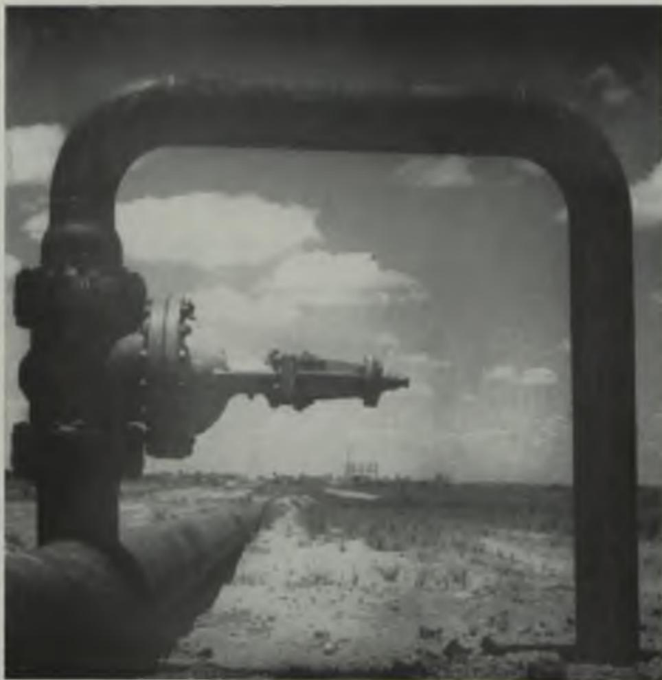
Válvula donde se enlaza una tubería de producción paralela al conducto principal tendido entre Josepín (Estado Monagas) y Puerto La Cruz
