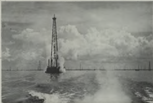
La perforación de pozos petrolíferos en el interior del Lago de Maracaibo, a más de significar gran adelanto técnico y científico, utilizó
