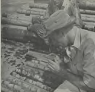
Los geólogos clasifican las rocas estratificadas en la profundidad del pozo. La perforación precisa sobre cualquier se soprar 500 toneladas.
