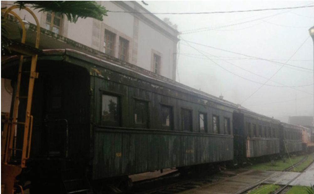
Perspectiva exterior de los vagones donde se observan daños por el abandono. Fotografía: Alfonso, 2016.
