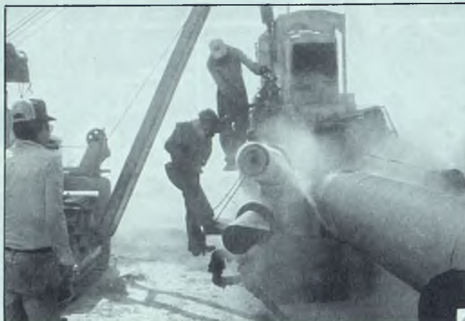
Revestimiento de Tubería Oleoducto Jobo/Pilón-Morichal
