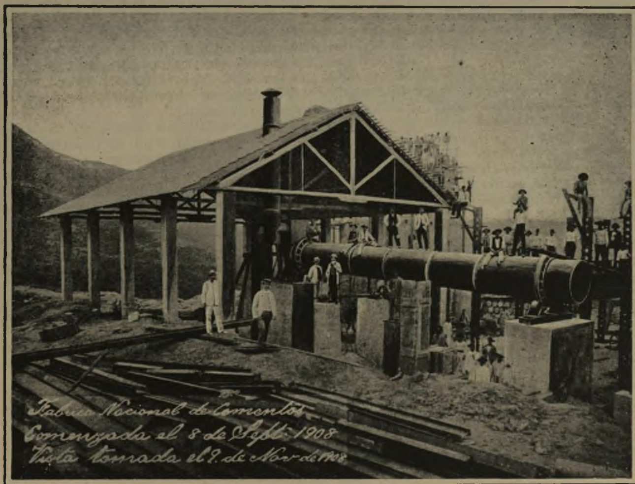
Fábrica Nacional de Cementos.—Vista tomada durante la construcción del edificio y montura de las máquinas.
