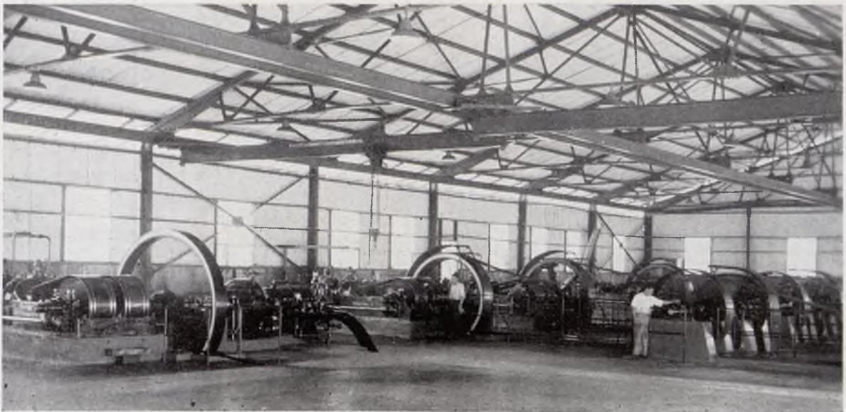
ESTACION PARA BOMBEAR EL AGUA
