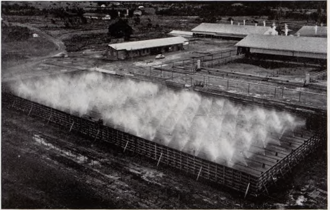
EL TANQUE PARA ENFRIAR EL AGUA DE CIRCULACION
