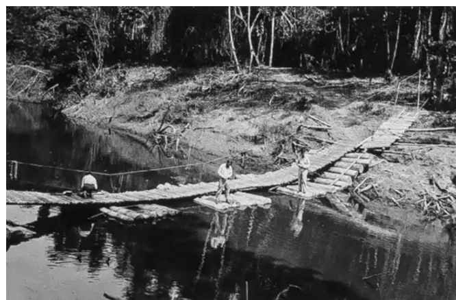
Figura 8. Construcción de un puente flotante para atravesar el río Victoria (Concesión Barco). Datatio incerta entre 1932-1936. Fuente: Colombian History – The Barco Concession https://sites.google.com/view/barcoconcesssionhistory/home
