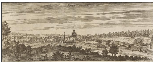
Figura 21. Grabado de la localidad de Avesta (1704) del libro de Erik Dahlbergh (1625-1703), donde se destaca en la parte central derecha de la imagen, un edificio o fragua de procesamiento de cobre con hornos, dividida a lo largo del curso del río el cual proporcionaba la fuerza motriz para una serie de ruedas hidráulicas. Tomado de https://suecia.kb.se/suecia/pdf/54/18471454.pdf
