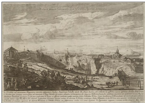
Figura 24. Grabado que ilustra la mina de Falun (1701) del libro de Erik Dahlbergh (1625-1703), junto a las instalaciones del acopio minero, donde se destaca en la parte central el cráter de 390 m de diámetro y 97 m de profundidad que se originó en el año 1687 y al cual hizo referencia Miranda en su descripción de esta mina. Tomado de https://suecia.kb.se/suecia/pdf/45/8533845.pdf
