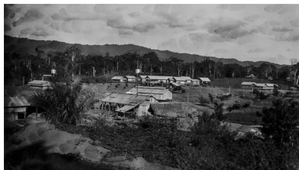
Figura 13. Campamento Petrólea de la Colombian Petroleum Company (Concesión Barco). Datación incierta entre 1933-1936.
