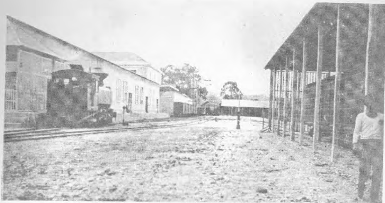
Gran Ferrocarril del Táchira. Depósitos, Oficinas y Departamentos para el material rodante en la Estación Táchira. Fotografía tomada de la Memoria del Ministerio de Obras Públicas 1916, Tomo I, p. 93. Copia de Reproducción: Najib Madrid. Autorizada por el Instituto Autónomo Biblioteca Nacional de Venezuela.
