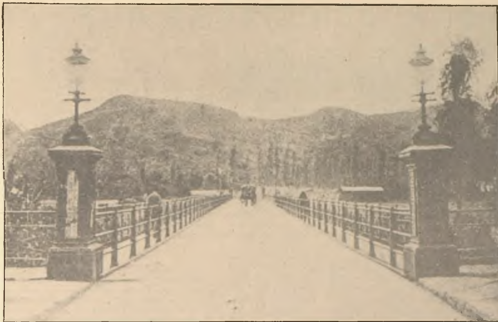
PUENTE DE HIERRO (De fotografía de Lesmann)
