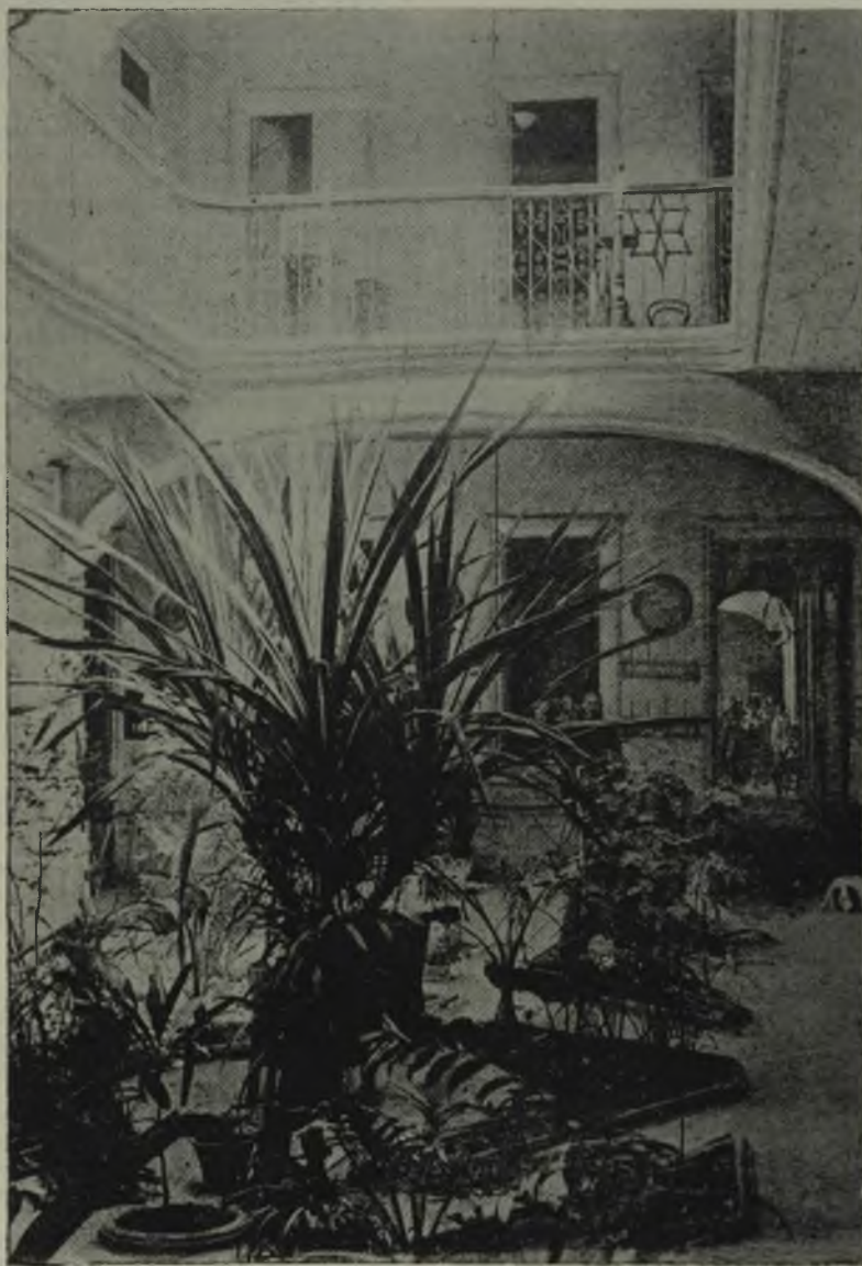
CARACAS: INTERIOR DEL HOTEL KLINDT
