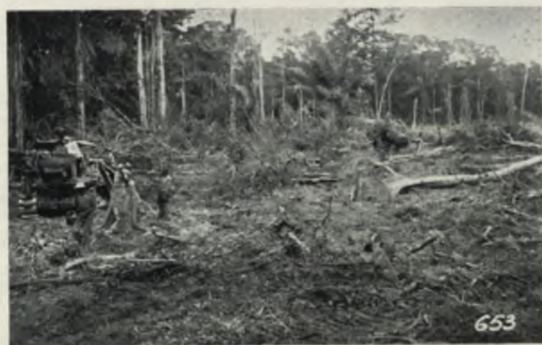
Una vez terminados los trabajos de agrimensura la primera preocupación consiste en despejar la proyectada ruta de la vegetación selvática.
