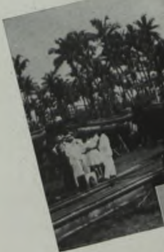
Los alumnos, admirados, toman datos en el patio de construcción de pilotes.
