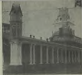
Edificio del Poder Judicial. En el Centro del Poder Judicial.
