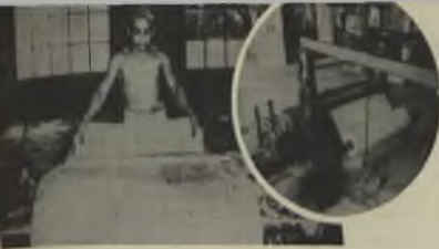
En el círculo, rebobinado del papel; y luego, de arriba abajo: desintegración y mezcla de la materia prima importada y nacional; refinación de la materia prima; entintado, etc. En esta última, recepción del papel ya elaborado en una bobina de 1.200 metros en las máquinas continuas.
