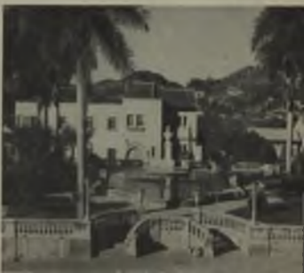
Las instalaciones de la comanda de la Sección de Inspección y Policía Militar en la Escuela Nacional de Guerra Aéreo (antigua), y de la escuela de Aviación y el aeropuerto de San Juan de los Ríos.
