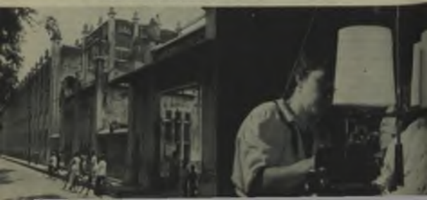
A la izquierda: vista general de la industria a las afueras de México. A la derecha: WOLMAN sistema de hilado automático.
